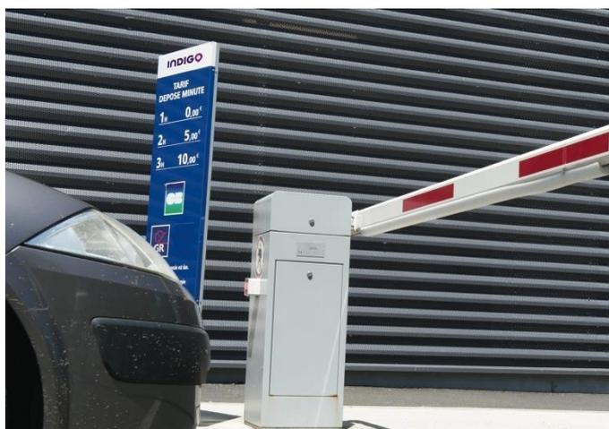
Un système de Lecture de Plaque Minéralogique (LPM) est mis en place dans les voies d'entrée et de sortie du parking.
